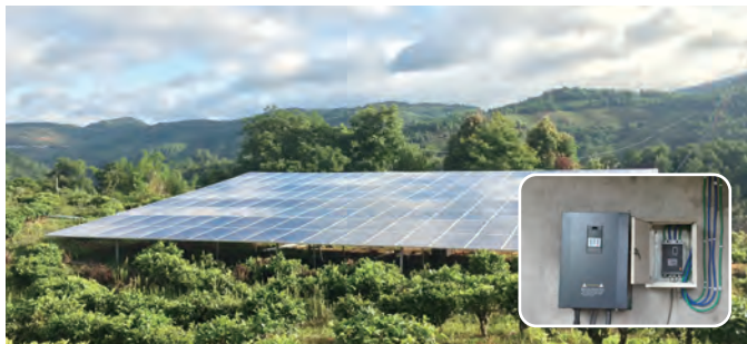
98kW 控制器：2*PDS33-4T037 地址：云南省临沧市
