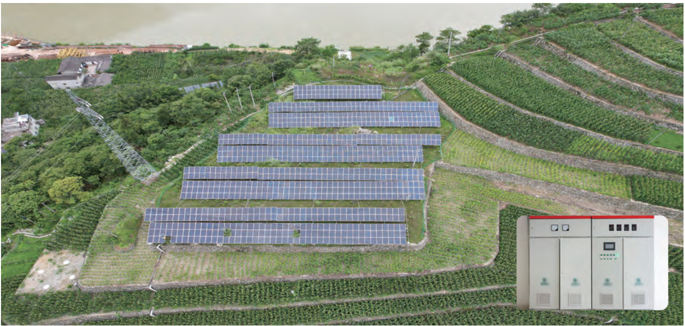
246kW 控制器：2*PDS33-4T075 + 2*PDS33-4T015 地址：四川省泸定县
